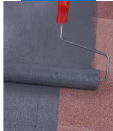
Εφαρμογή Eco Prim Grip με ρολό σε υφιστάμενο δάπεδο από πλάκες μωσαϊκού
