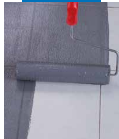
Εφαρμογή Eco Prim Grip με ρολό σε υφιστάμενο δάπεδο από πλακίδια τεχνητού γρανίτη
