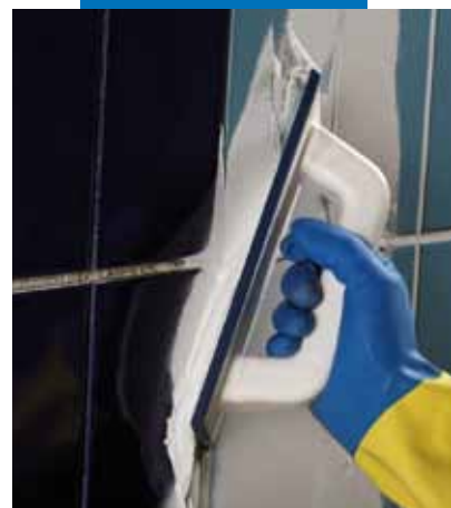
Εφαρμογή του Κεραροxy CQ σε τοίχο με σπάτουλα MAPEI
