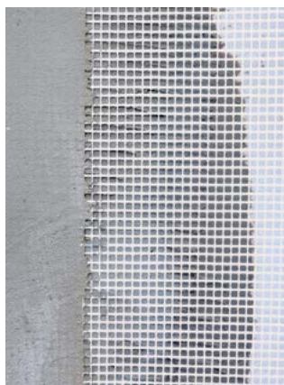
Ενίσχυση των γωνιών σε ανοίγματα
